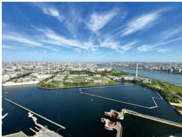
砂町水再生センターと東部スラッジプラント
