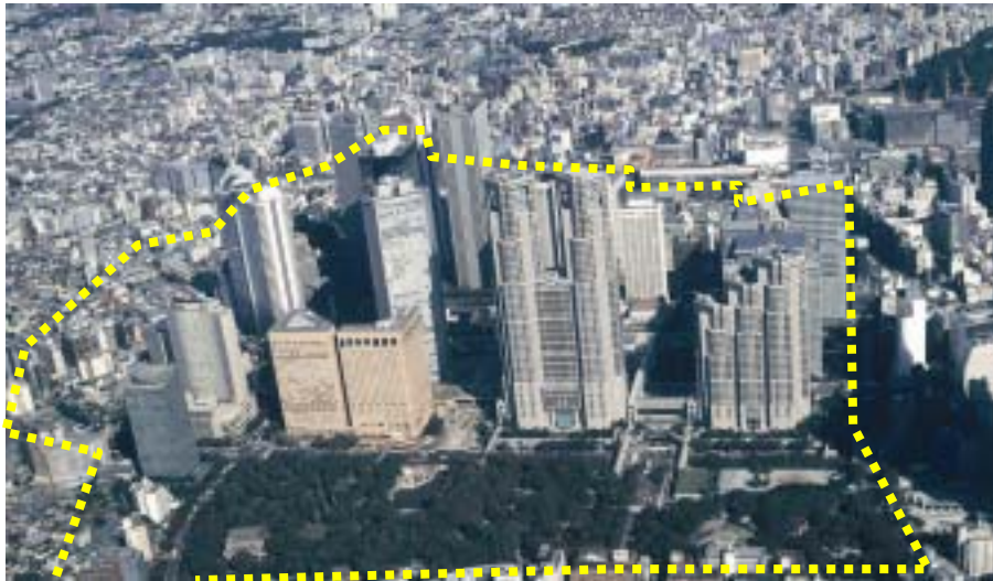
再生水の供給（西新宿地区）
