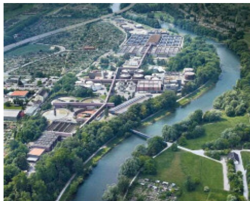
下水処理場全景※1
