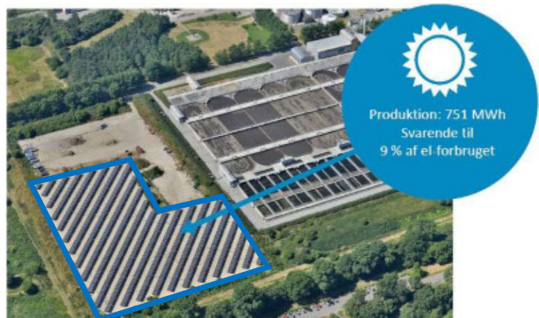
太陽光発電設備(Damhusåen 処理場)※2
