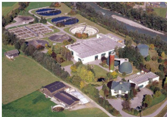
下水処理場全景※1
