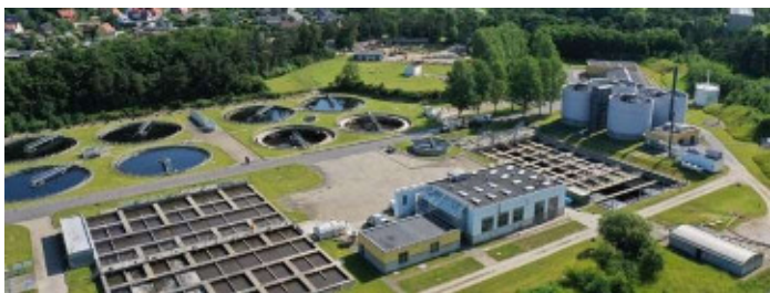
下水処理場全景※1
