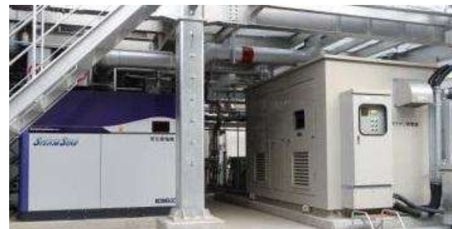
スクリー式 (左) とバイナリー式 (右) 発電機
