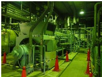
汚泥消化ガス発電(消化槽・発電機) (3,200kW: 森ヶ崎水再生センター)
