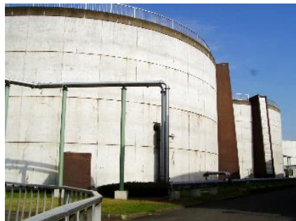
汚泥消化ガス発電(消化槽・発電機) (3,200kW: 森ヶ崎水再生センター)
