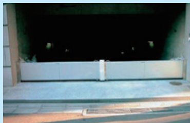
長い板を使った止水板
