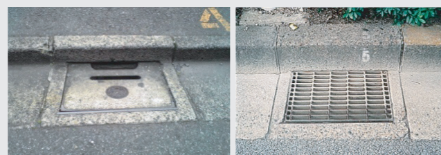
道路上の公共雨水ます
