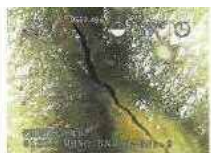
↑老朽化により下水道管が損傷 ※拡大写真
