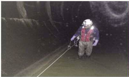
幹線の点検(北多摩二号幹線)
