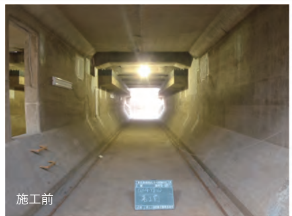
施設の耐震化実施例(コンクリート増打ち) (南多摩水再生センター)
