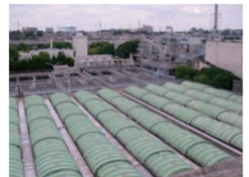
八王子市・北野下水処理場
