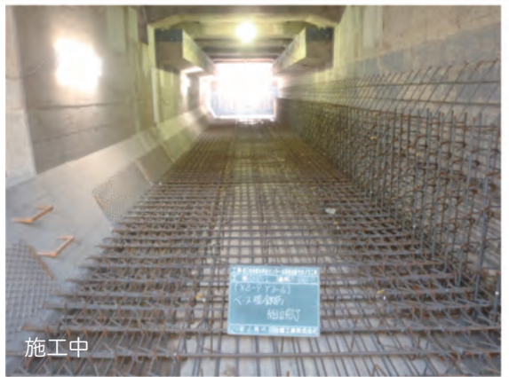
施設の耐震化実施例(コンクリート増打ち) (南多摩水再生センター)
