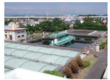
立川市・錦町下水処理場
