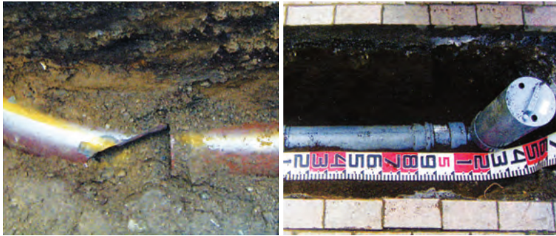
(左：損傷した陶管製の取付管 右：硬質塩化ビニル管に取替えた取付管)
