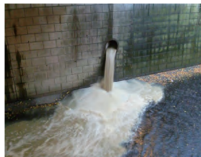
雨天時の合流式下水道の吐口からの放流
