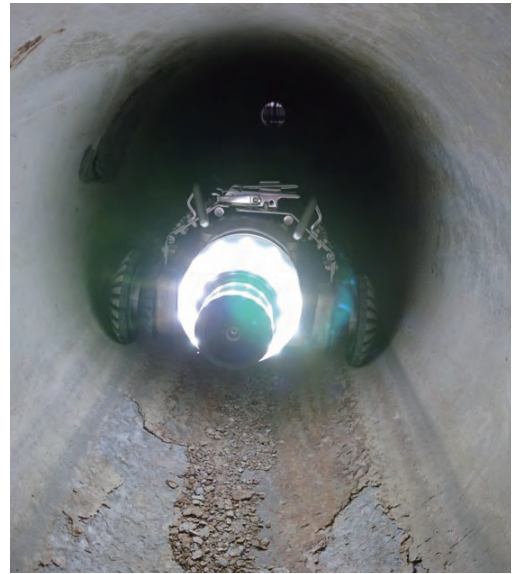
(ミラー方式テレビカメラによる下水道管の調査)
