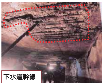
写真2-1 下水道管きよの老朽化の状況
