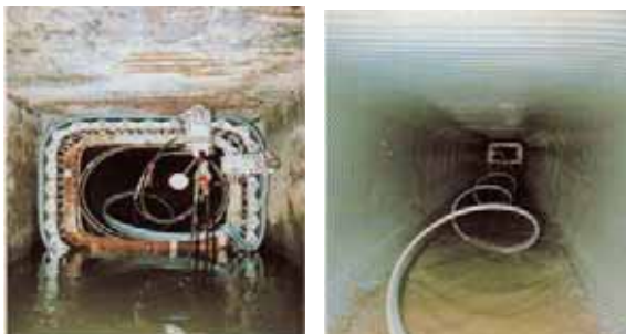
写真1-1 老朽化した下水道幹線の更生の一例
