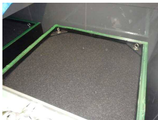
臭気を吸着する脱臭剤(脱臭装置内部)
