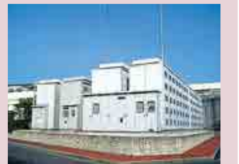
▲NaS電池設備
