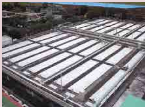
▲雨天時貯留池(北側)の上部
