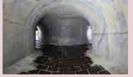
▲唧筒井接続暗渠
