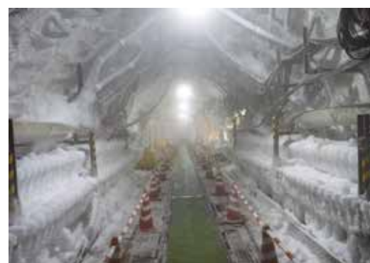
図11 凍結中の坑内状況
