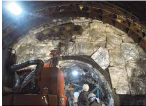
図13 セグメント組立状
