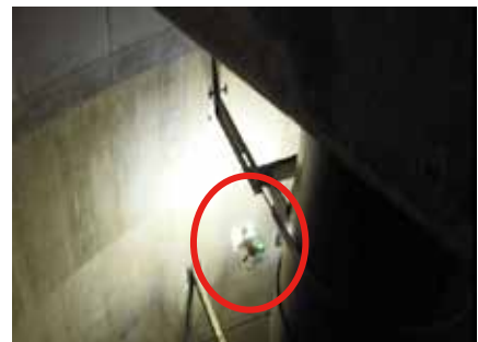
図3 ドローン調査状況
