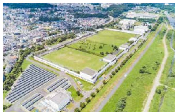
図2 八王子水再生センター
