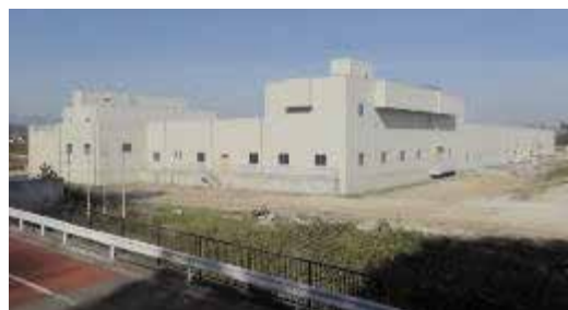
図6 新たに建設した水処理施設（第5系列）
