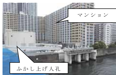
図 4 ふかし上げ人孔付近の状況
