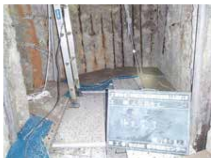
図 7 吊り足場設置状況(上流人孔)
