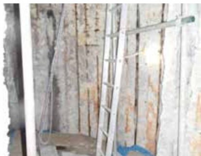
図9 D種シートライニング施工前
