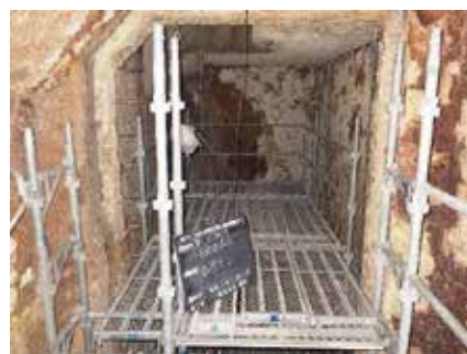
図 8 吊り足場設置状況(下流人孔)
