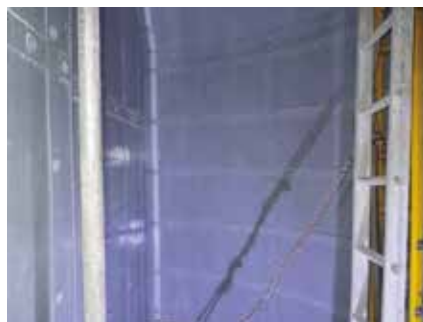
図10 D種シートライニング施工完了
