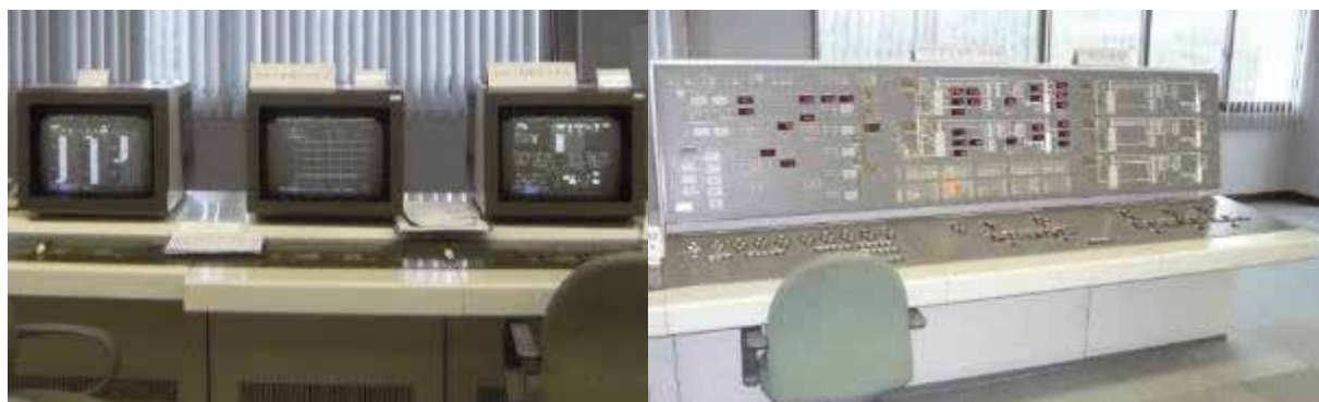
図2 再構築前監視室（八王子水再生センター）
