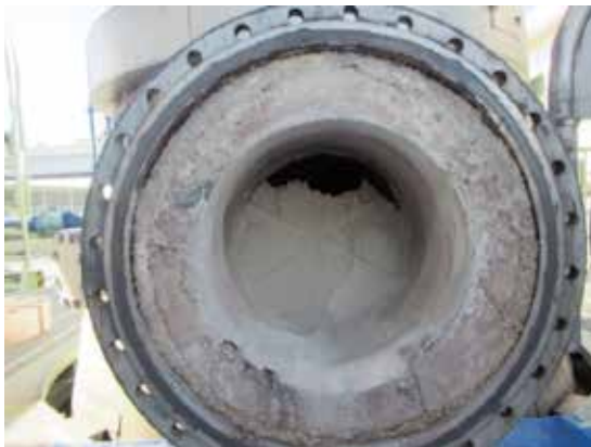
図 1 空気予熱器上部（煙道閉塞時）
