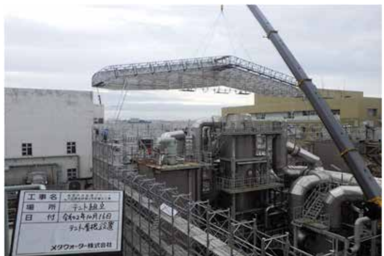
図4 テント(屋根部)設置状況
