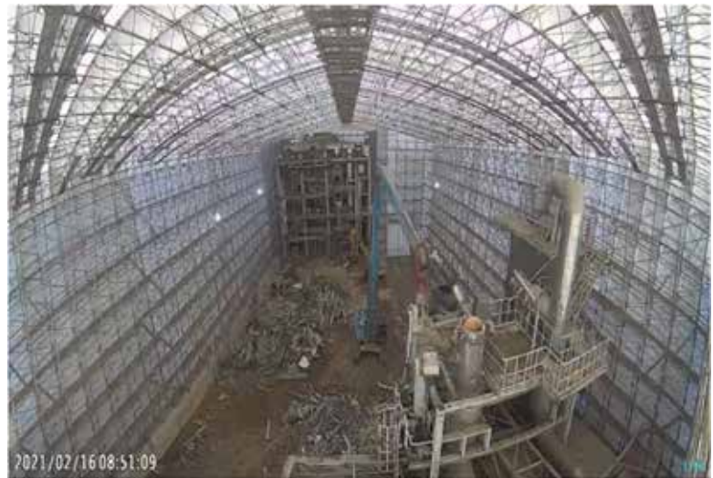
図6 機器撤去状況（ウェブカメラ）
