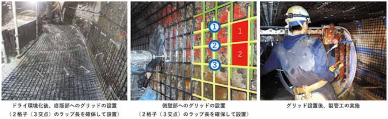
図 15 試行工事の施工状況
