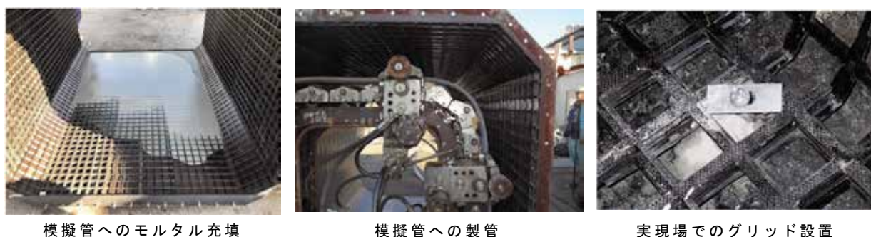
図10 模擬管と実現場での施工性確認
