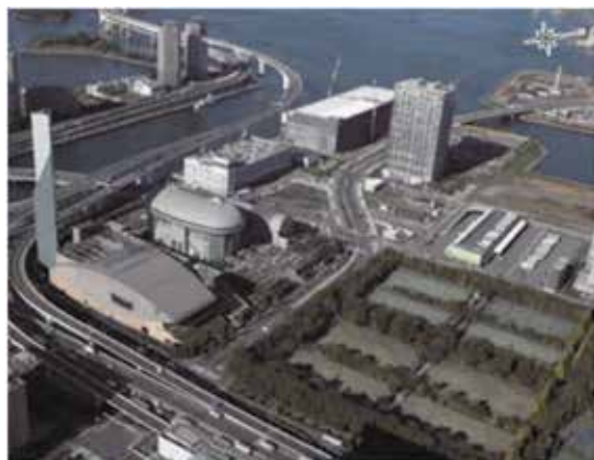
図 4 有明水再生センター
