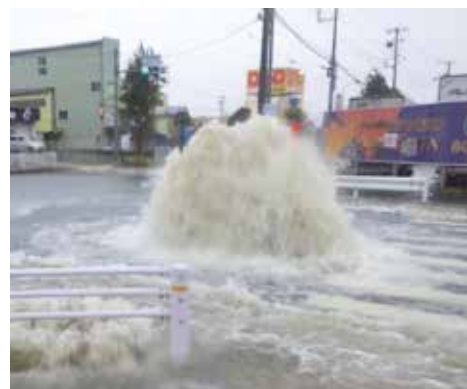
写真1 流域下水道幹線からの溢水状況
