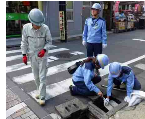
雨期前の雨水ます清掃作業
