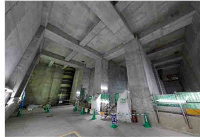
大規模なまちづくりに併せて 民間事業者と連携して整備した 雨水貯留施設(渋谷駅東口)
