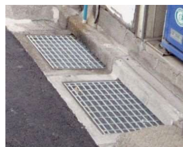
グレーチング蓋への取替え
