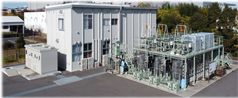
下水技術研究開発センターの実験棟（中央）水処理実験プラント（右）
