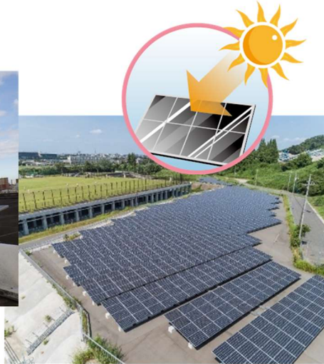
再構築用地への設置例
