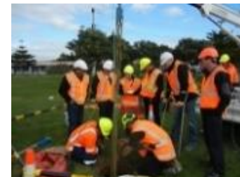
【フロートレス工法の試験施工】
