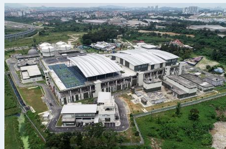
【ランガット下水処理場】
