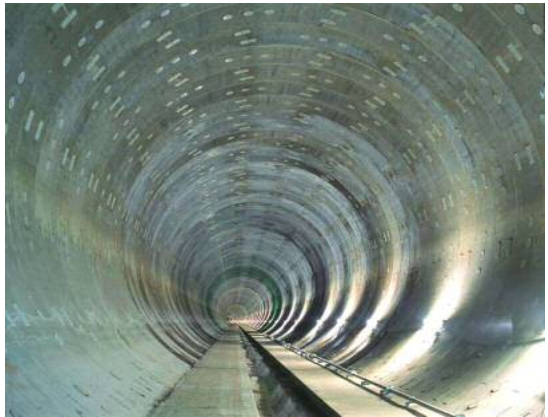
和田弥生幹線 (貯留管：直径8.5m、延長2.2km)
