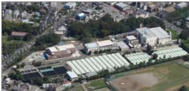
立川市 錦町下水処理場（昭和42年稼働）
