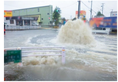
マンホールからの溢水被害
