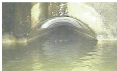
管内水位が高く老朽化した幹線（乞田幹線）
