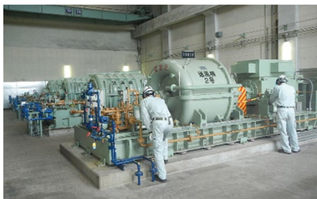
送風機の点検 (北多摩一号水再生センター)
