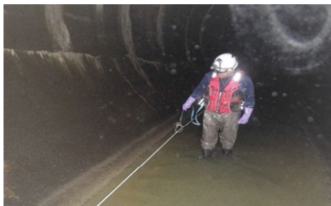
幹線の点検（北多摩二号幹線）
