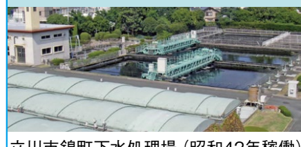
立川市錦町下水処理場（昭和42年稼働）
