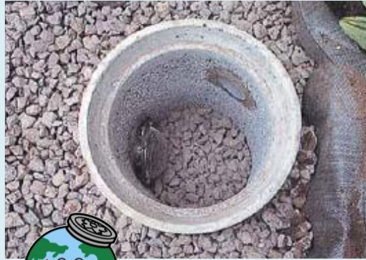
雨水浸透ます (直径15~50cm程度)
