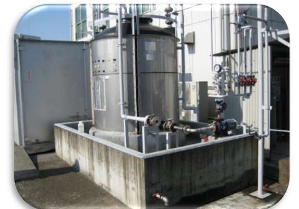
薬品タンクに防液堤を設置
