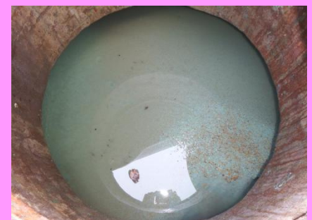
汚泥を溜めすぎ、越流した沈殿槽
