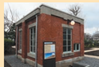
⑤ 土运车牵引装置用电动机室 安装的机器可把装有污水中清除出的沙土和垃圾的挖泥车吊上坡。
