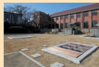
⑥ 量水器房 地下安装的文丘里流量计可测量污水量。
