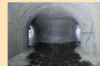
⑦ 吸水井连接暗沟及吸水井 分为两个系统流入的污水在这里汇合，流入各自的吸水井。
