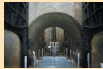
⑦ 吸水井连接暗沟及吸水井 分为两个系统流入的污水在这里汇合，流入各自的吸水井。
