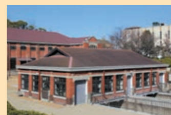
④ 滤格室棚 安装的钢网可清除污水中垃圾。
